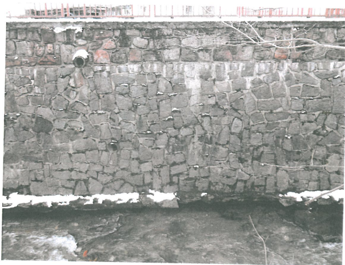
Obr. 2 Foto zahloubení dna včetně poškozené a částečně odplavené bet. základu
